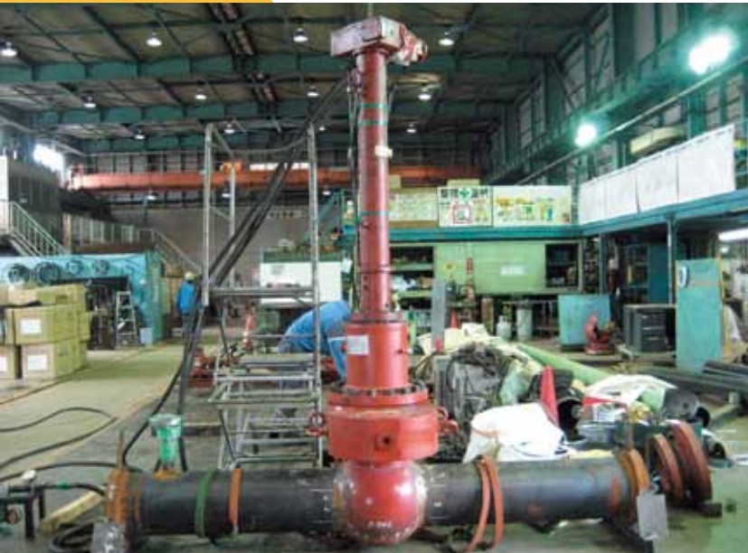
●300A同径分岐継手にて穿孔作業を行っているところです。
