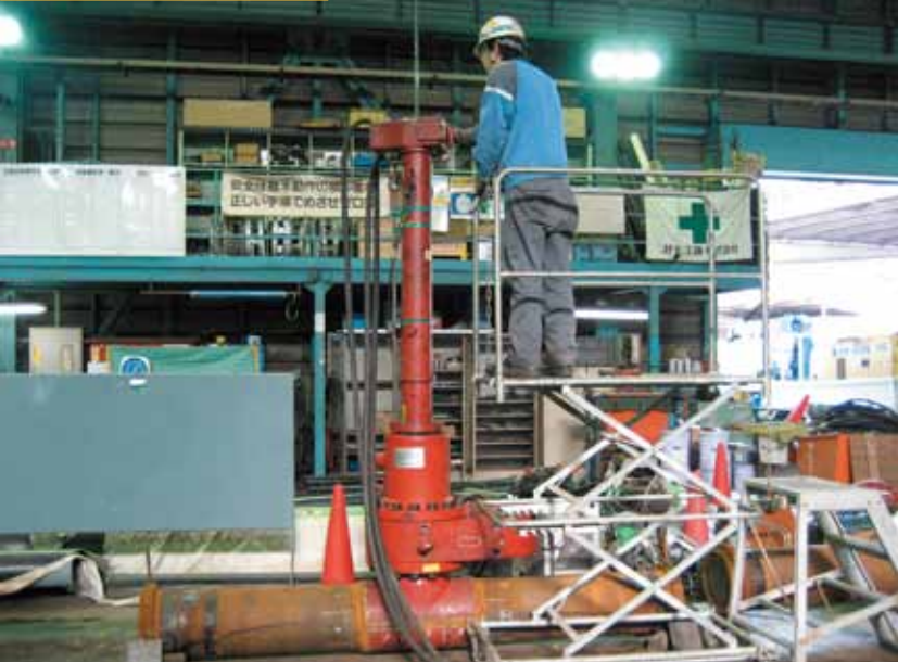
●300A同径遮断継手にて穿孔作業を行っているところです。
